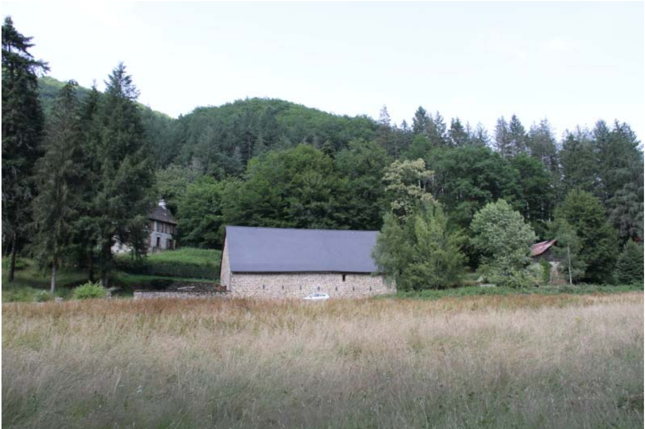
Grange du Pestre, forêt domaniale de Miers, camp de base de l'opération
