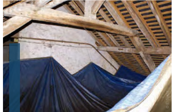
Bâches de protection dans un comble
